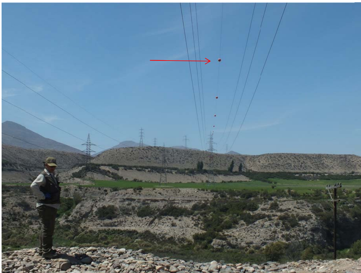
Figura 1. En la figura se aprecia la instalación de balizan distractoras de avifauna para el sector del cruce río Huasco.
