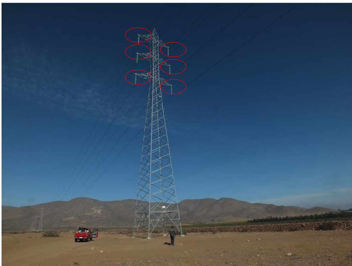
Figura 2. En la imagen se destacan la disposición de peines para una torre del tramo de la línea de transmisión eléctrica.
